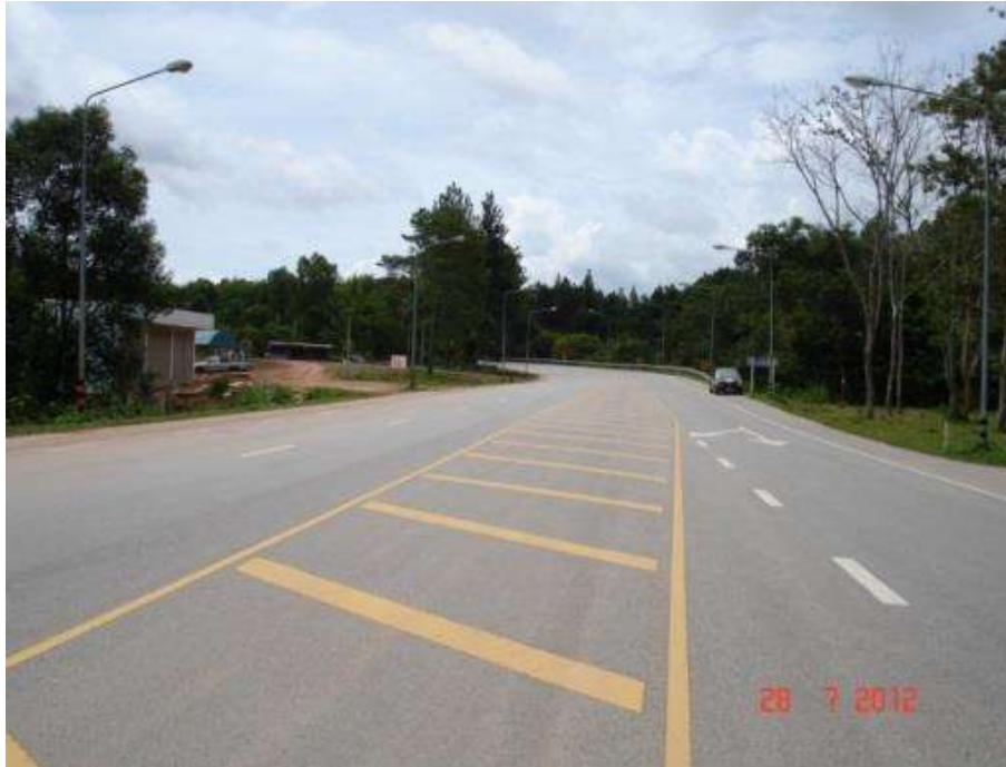
ก่อนเริ่มก่อสร้าง
