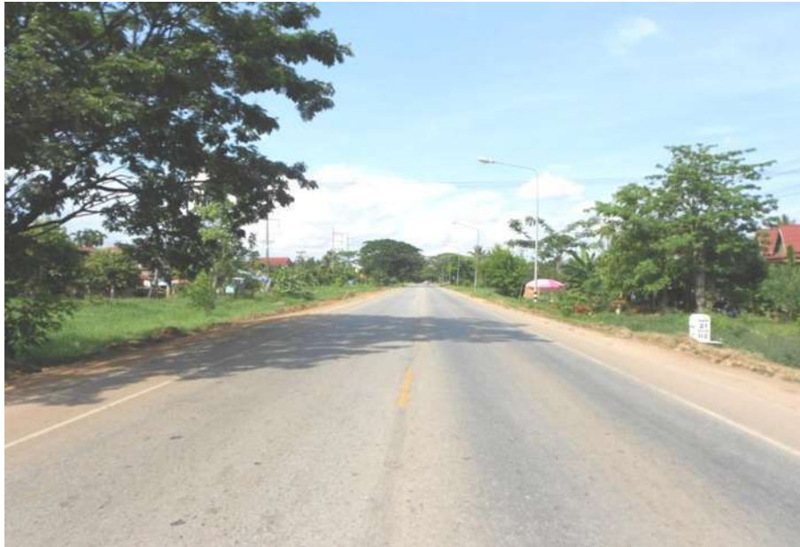
ก่อนเริ่มก่อสร้าง
