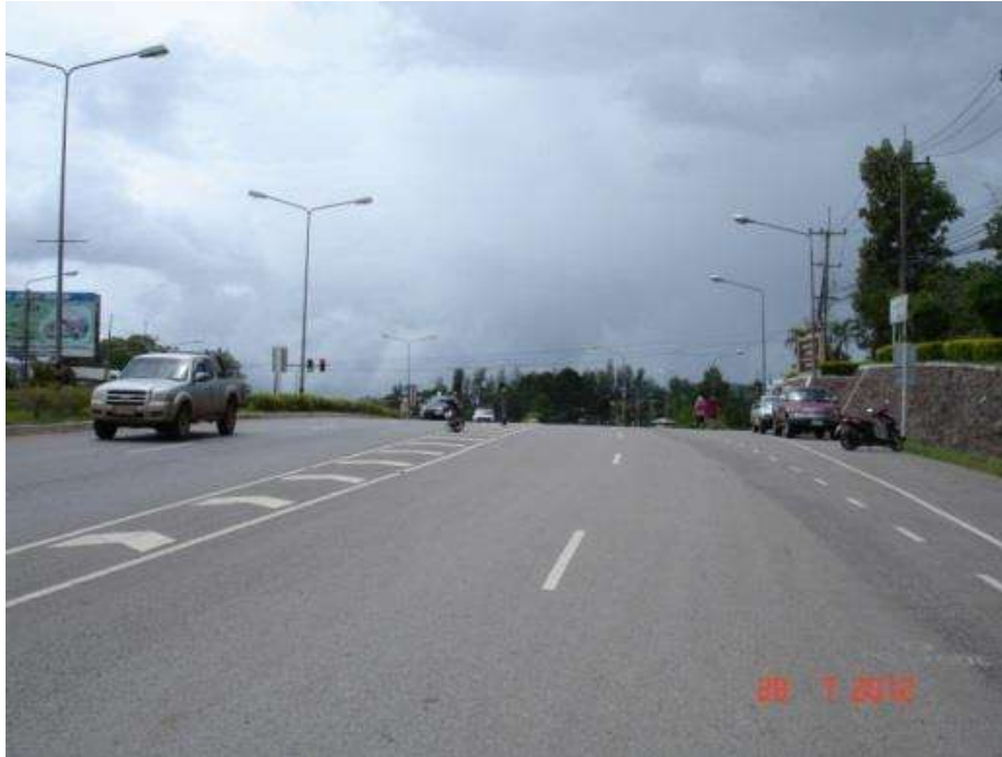
ก่อนเริ่มก่อสร้าง
